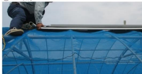
① PV 取付
